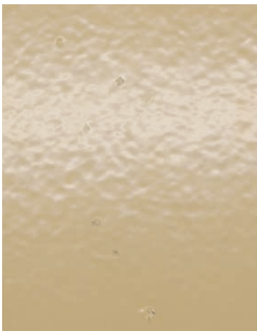
Los poros son difíciles de localizar en una inspección con luz blanca.
