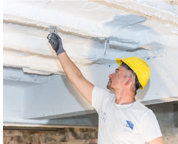
Messung der Nassfilmschichtdicke direkt nach der Applikation
