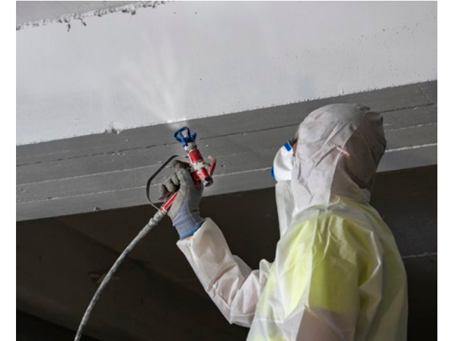
Die Applikation erfolgte im Airless-Spritzverfahren direkt auf die Betondecke
