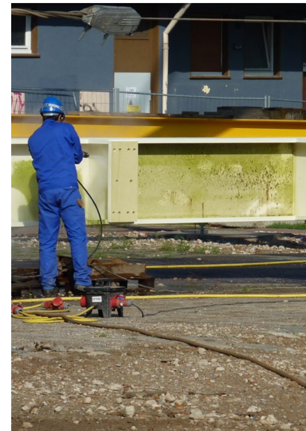
Hochdruckreinigung der Stahlträger
