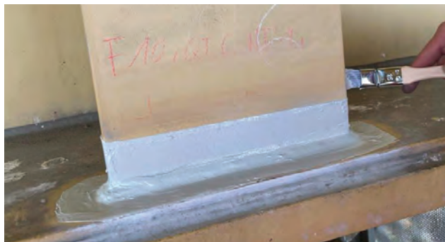
Utilisation d'un pinceau pour étaler uniformément le matériau de revêtement à 2 composants.
