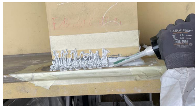
Facile applicazione di Repacor SW-1000 su un cordone di saldatura grazie alla sua cartuccia maneggevole.
