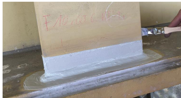
Distribuzione uniforme del materiale del rivestimento bicomponente mediante pennello.
