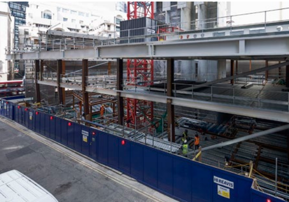
Zdjęcia dzięki uprzejmości Bourne Steel Ltd.
